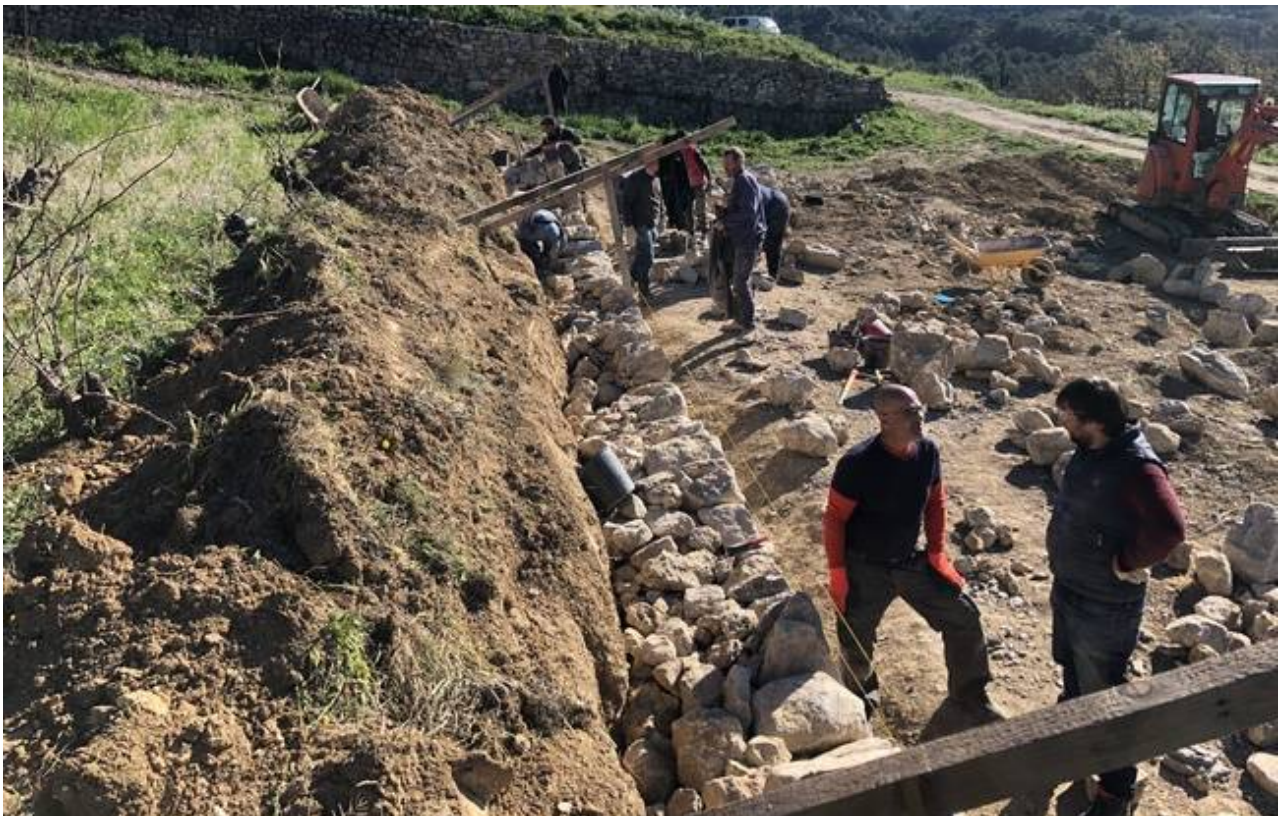
Les murs en pierres sèches sont assez large pour soutenir le sol. - Adrien Max / 20 Minutes
