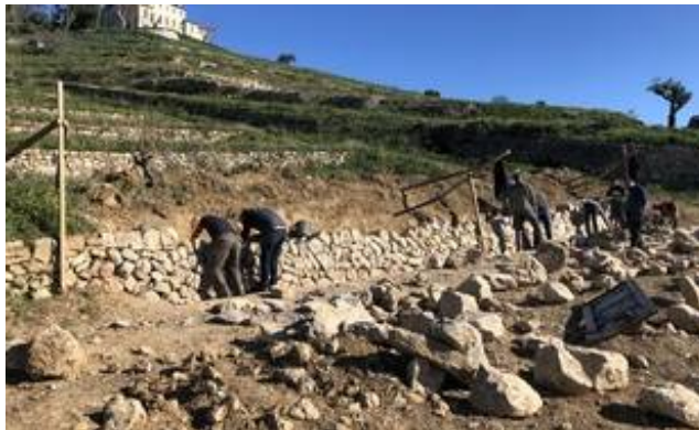
Le mur en pierre sèches réalisé au cours d'une formation dans le Var. — Adrien Max / 20 Minutes
