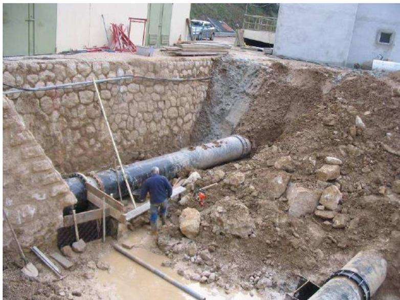
**Fig. 50. Vue depuis l'amont de la conduite de prise et du bajoyer de l'ancien chenal d'évacuation des vidanges**
