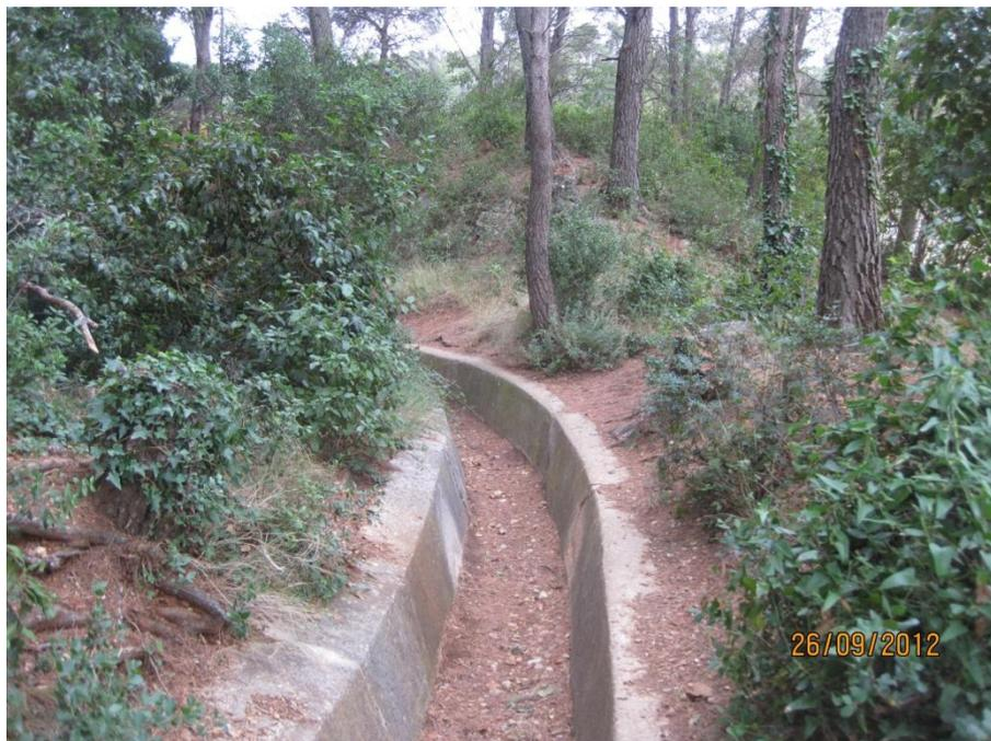
Figure 7: Canal de colature (rive gauche du barrage).
